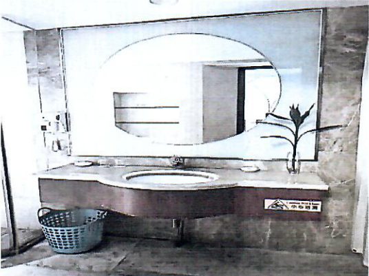
台面大理石破损盆底脱落
