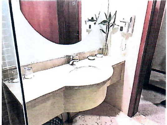
台面大理石破损盆底脱落
